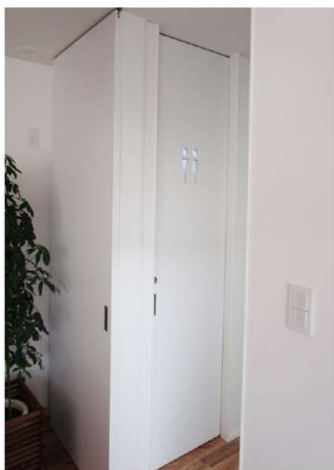
ルーター加工によるピクトグラム明かり窓
